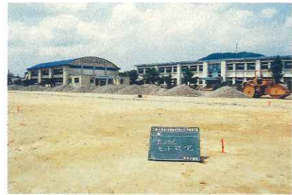
〈施工順1〉セットした状況
