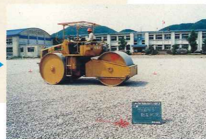
〈施工順4〉碎石転圧状況
