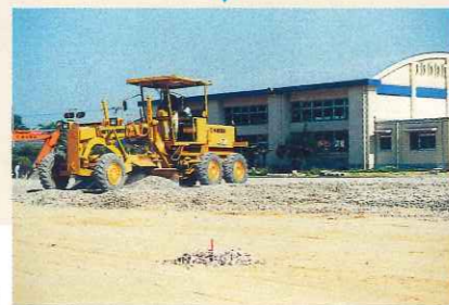
〈施工順3〉碎石敷均し状況
