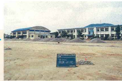
〈施工順2〉保護した状況
